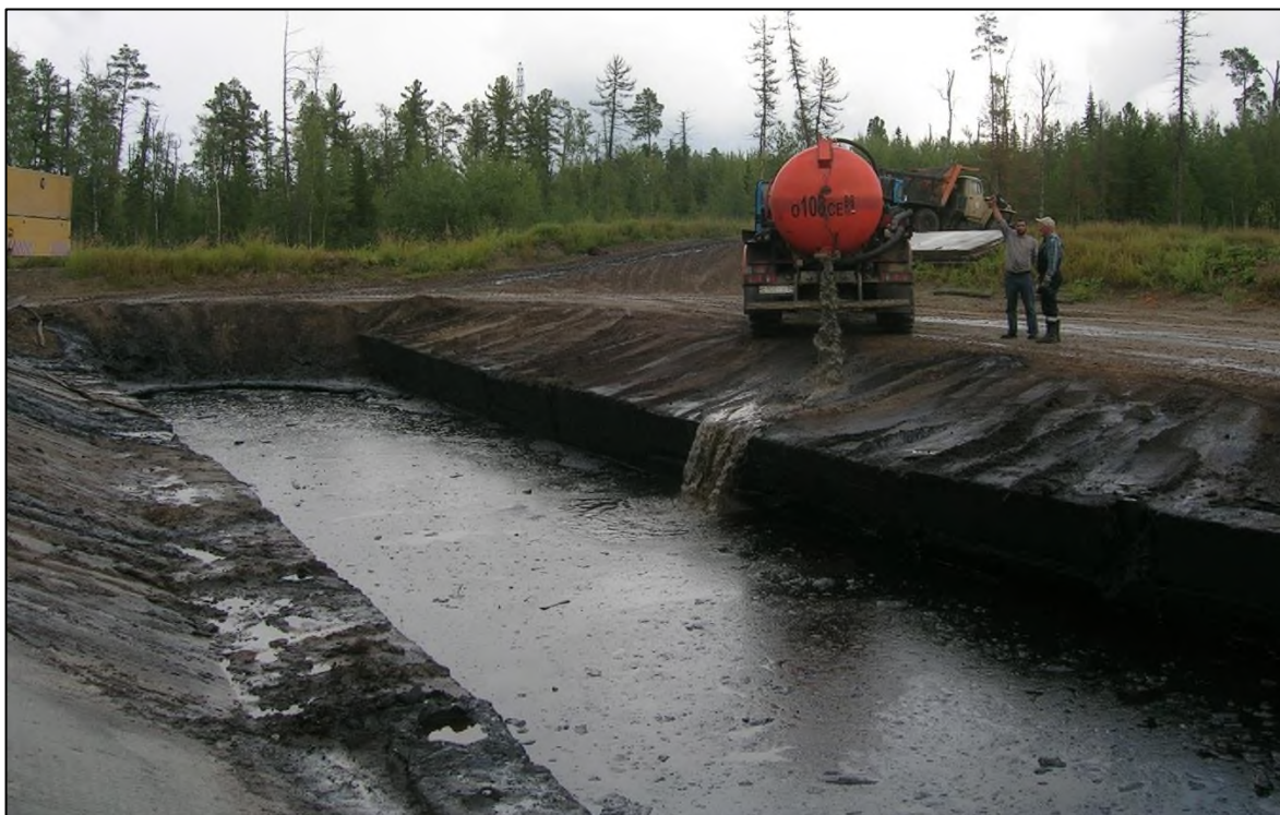
Рисунок № 7. Выгрузка жидких нефтесодержащих отходов в накопительную карту шламонакопителя.
